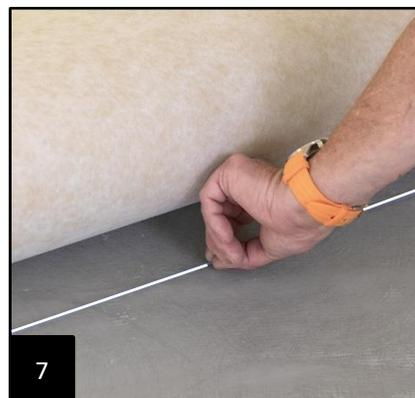
Rabattez ou faites rouler les bandes vers le centre de la pièce (6). Pour une pose parfaitement rectiligne de la colle, utilisez un cordeau à tracer (7).
