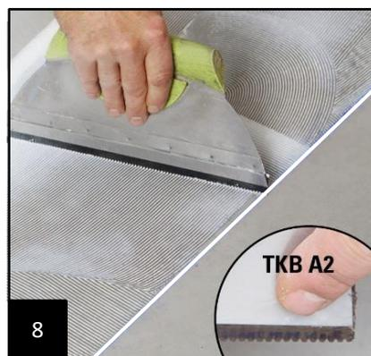
Étirez la colle homologuée par Windmüller GmbH conformément aux instructions du fabricant de ce dernier à l'aide de la spatule dentée TKB prévue à cet effet (généralement avec denture A2 TKB), en procédant par bande et de manière homogène (8).
