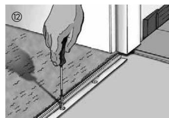
Pour maintenir le jeu de dilatation aux seuils des portes, utiliser toujours un système de profil adapté. Procéder de la même manière pour la pose « continue » dans une pièce contiguë. Dans ce cas, un joint de dilatation est nécessaire, il sera masqué avec un profil de même-niveau.
