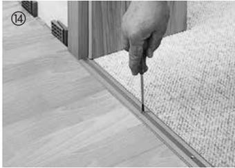
14 Un jeu de dilatation d'environ 5 mm sera respecté dans le profil. Le bas du montant de la porte doit être coupé avec une scie fine à hauteur de l'épaisseur de l'élément pour que le revêtement de sol stratifié puisse se dilater sous le montant. Une fois la pose terminée, il est impératif d'enlever les cales. Visser les plinthes (avec ou sans système à clips) au mur – c'est terminé !
