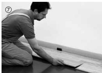
⑦ La deuxième rangée peut être commencée avec le reste de la première rangée (décalage des joints en bout d'élément d'au moins 50 cm). Ainsi on évite trop de chutes. Poser les autres lames les unes après les autres. Pour ce faire, les lames sont d'abord emboîtées sur la longueur sous l'effet d'une légère pression exercée dans la liaison.
