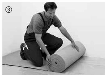
③ Pour l'isolation phonique et l'égalisation des petites aspérités, il convient de dérouler jusqu'aux bords un rouleau de liège de 2 mm d'épaisseur. D'autres sous-couches isolantes alternatives sont également disponibles parmi notre gamme d'accessoires. Le carton bitumé ne se prête pas à l'isolation phonique. **Pour les sols stratifiés HARO Silent Pro<sup>®</sup>, ne pas poser de sous-couche isolante supplémentaire.**
