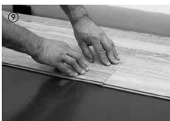
⑨ La lame est abaissée à l'about. Veillez à cet égard que la lame soit glissée sur l'about aux abords de l'arête de la lame posée précédemment. En appuyant légèrement sur le chant transversal, la lame s'enclenche.
