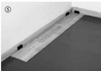
⑤ Pour commencer, poser les premières lames au coin droit de la pièce avec la languette côté mur et fixer à l'aide de cales biseautées (respecter un jeu de dilatation de 10 à 15 mm par rapport au mur).
