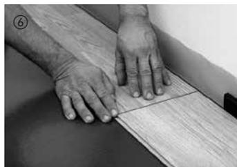
⑥ Les autres lames de la première rangée doivent être encliquetées par le haut au niveau des extrémités dans la lame précédente. En appuyant légèrement sur le chant transversal, la lame s'enclenche dans la lame voisine. Veillez à respecter un alignement exact des lames. La dernière lame de la première rangée est coupée en respectant le jeu de dilatation de 10 à 15 mm par rapport au mur et emboîtée.
