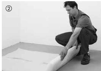
② En règle générale, il faut toujours poser un film en polyéthylène de 0,2 mm d'épaisseur sur toutes les chapes et lors d'une pose sur un chauffage au sol. Les raccords des feuilles doivent se chevaucher sur environ 30 cm. Relever la feuille sur le mur et la couper, après le montage des plinthes, sur l'arête supérieure de ces dernières.
