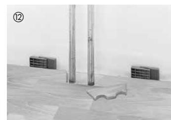
⑫ Découper ou percer des ouvertures pour les tuyaux de chauffage sortant du sol (selon la taille des tuyaux et sans oublier le jeu de dilatation).
